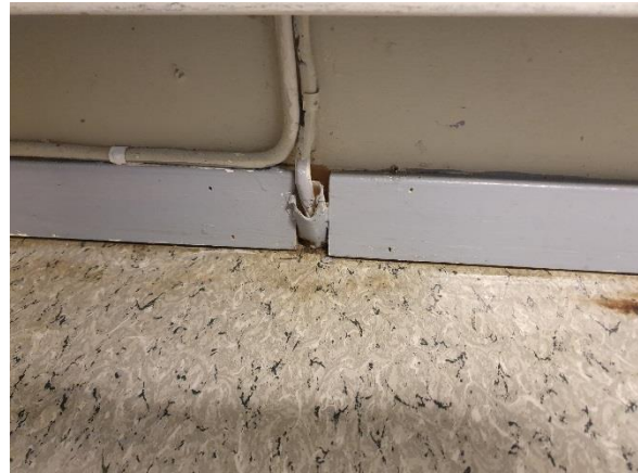
Foto 2. Det er også enkelte andre gjennomføringer ned mot gulvet, hvor test med røykblåse gir indikasjoner på luftbevegelser.
